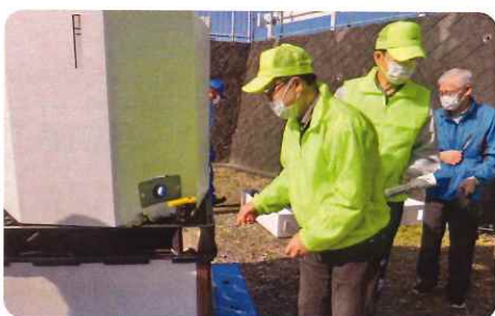
給水タンク設置
